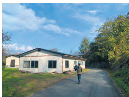
【工事前の事業所】
