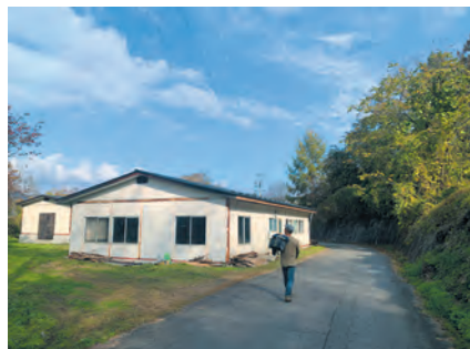
【工事前の事業所】
