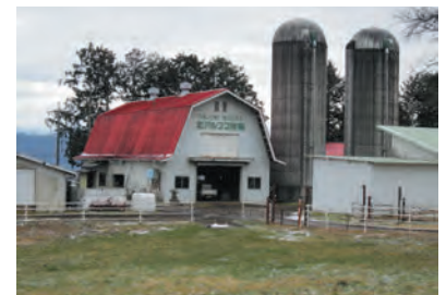
【(有)北アルプス牧場畜舎】
