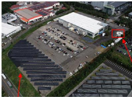
太陽光発電システム 容量:670kW
