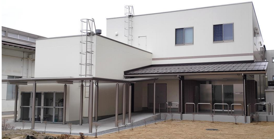
＜3Dデジタル生産技術共同研究棟＞
