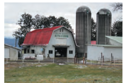
【(有)北アルプス牧場畜舎】
