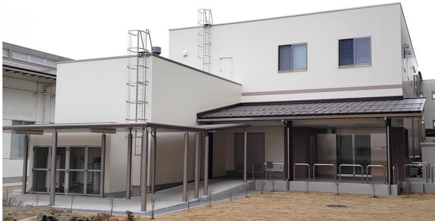
＜3Dデジタル生産技術共同研究棟＞
