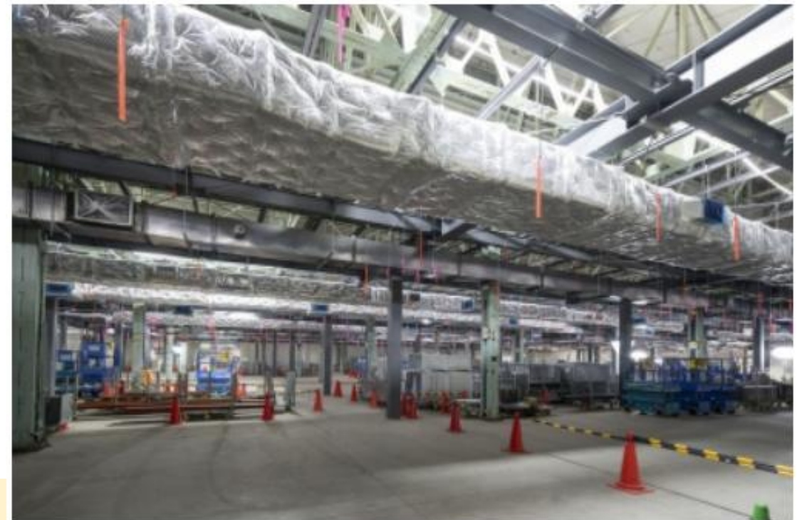
建設中のパイロット生産ライン（横浜工場）
