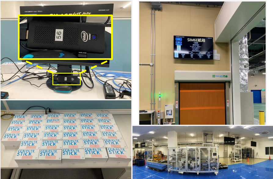
スティックコンピューター+モニターで 製造情報表示
